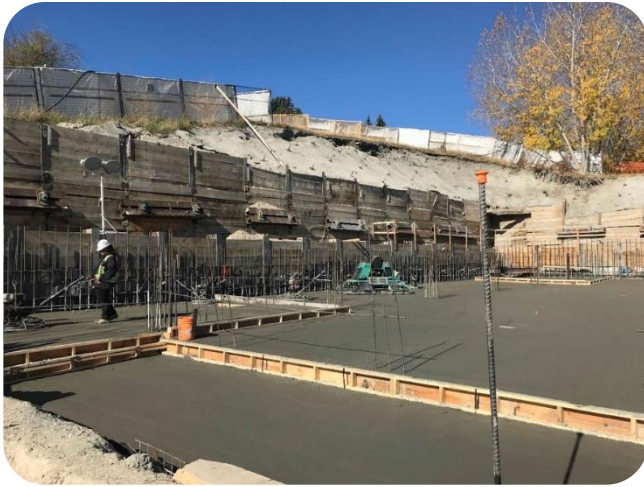
Main Floor slab – first pour
