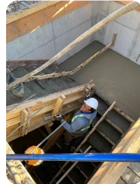
Stair – concrete pour
